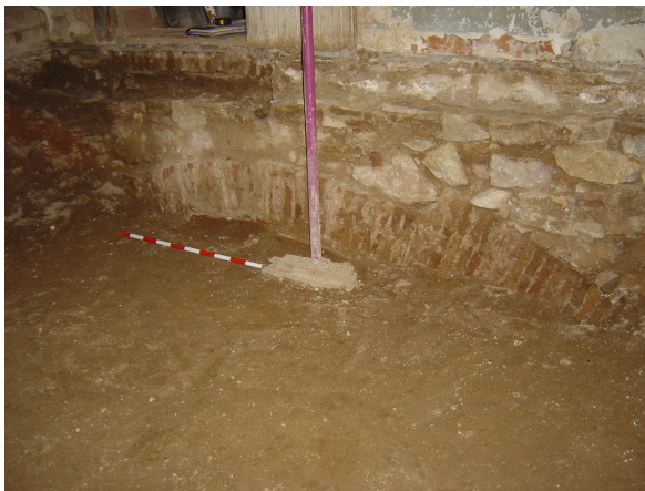
Vista de dues de les fonamentacions internes de l'edifici amb la presència de arcs de descàrrega o reforç. La primera -foto esquerra- correspon a la paret posterior (sud) de la vivenda i la segona - foto dreta - en desús, suporta avui dia el pes de pilars interns.
